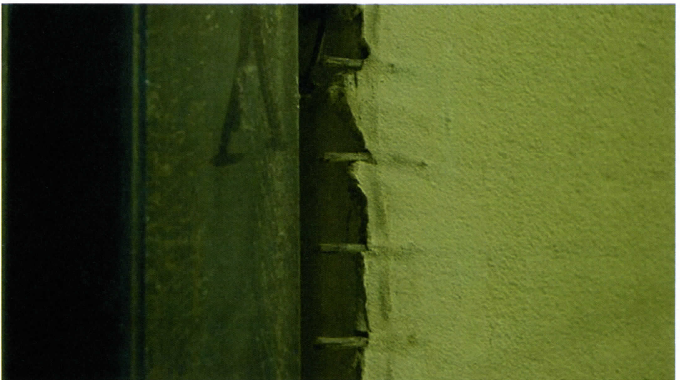
Рисунок 5.4.4 – Вертикальная армирующая базальтовая сетка в слое клея
