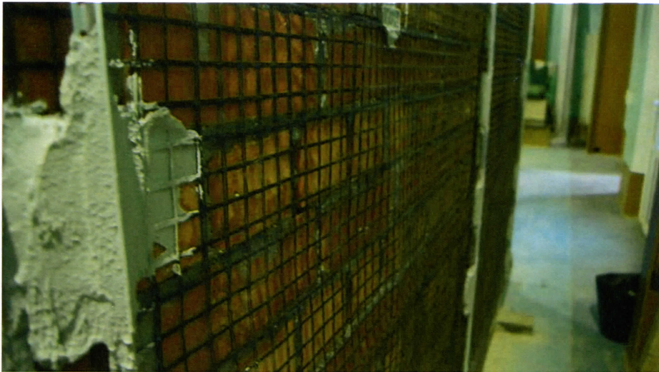
Рисунок 5.1.2 - Раскладка вертикальной арматуры
