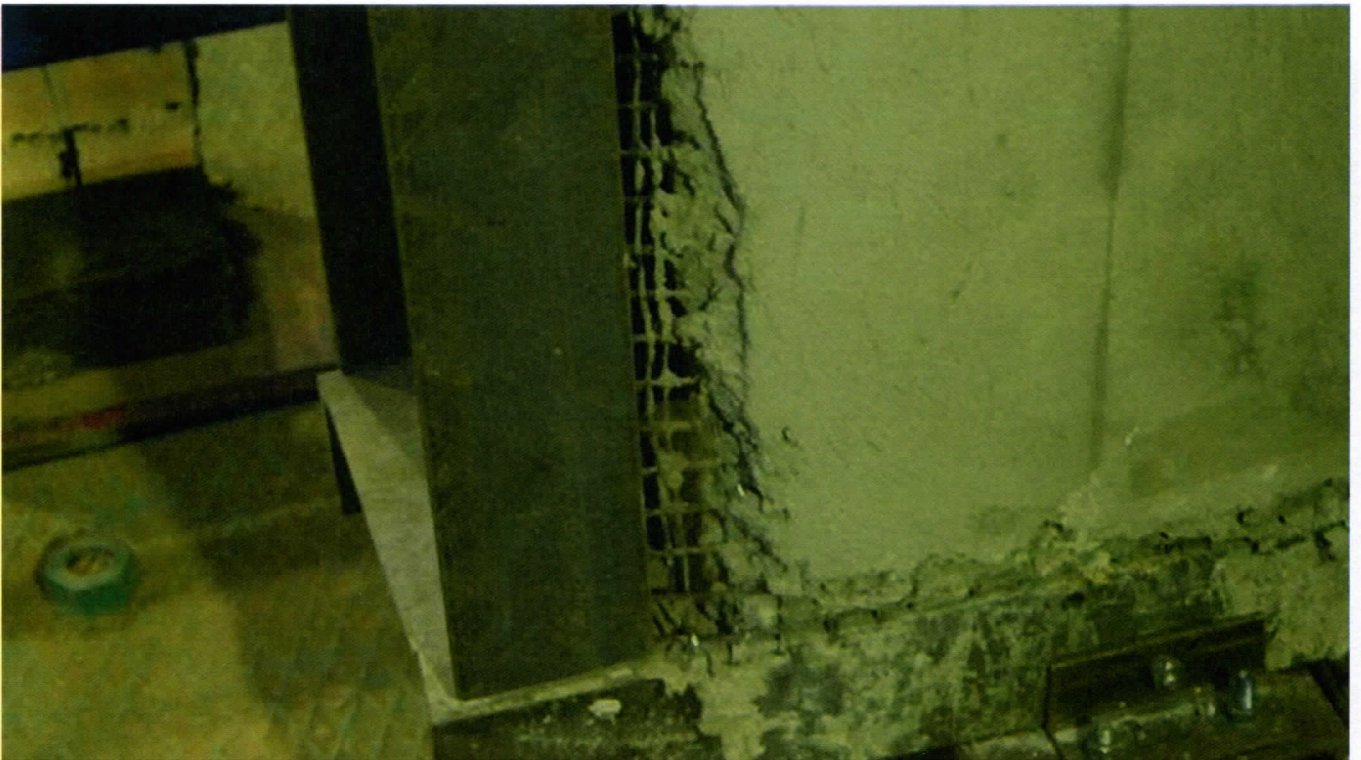
Рисунок 5.2.3 - Оштукатуривание перегородки
