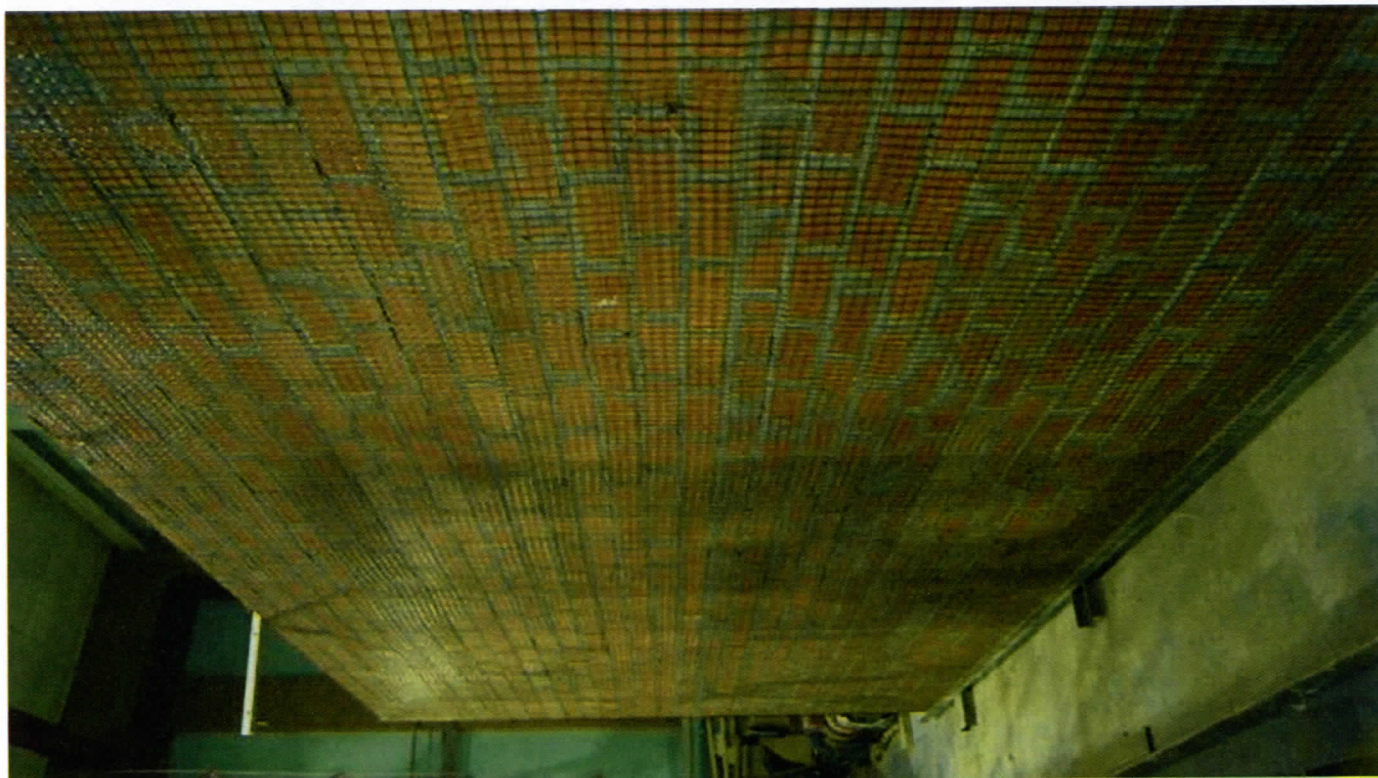
Рисунок 5.3.2 - Раскладка вертикальной арматуры
