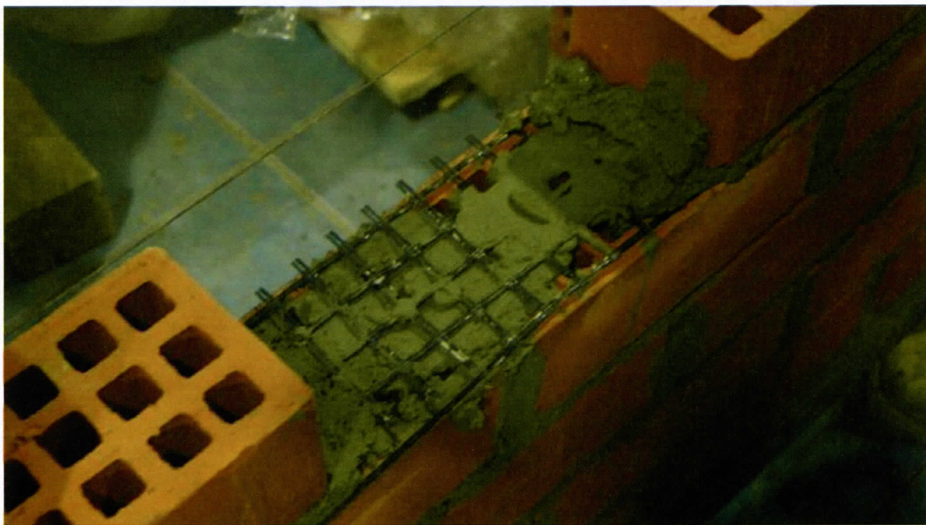
Рисунок 5.1.1 - Раскладка горизонтальной арматуры
