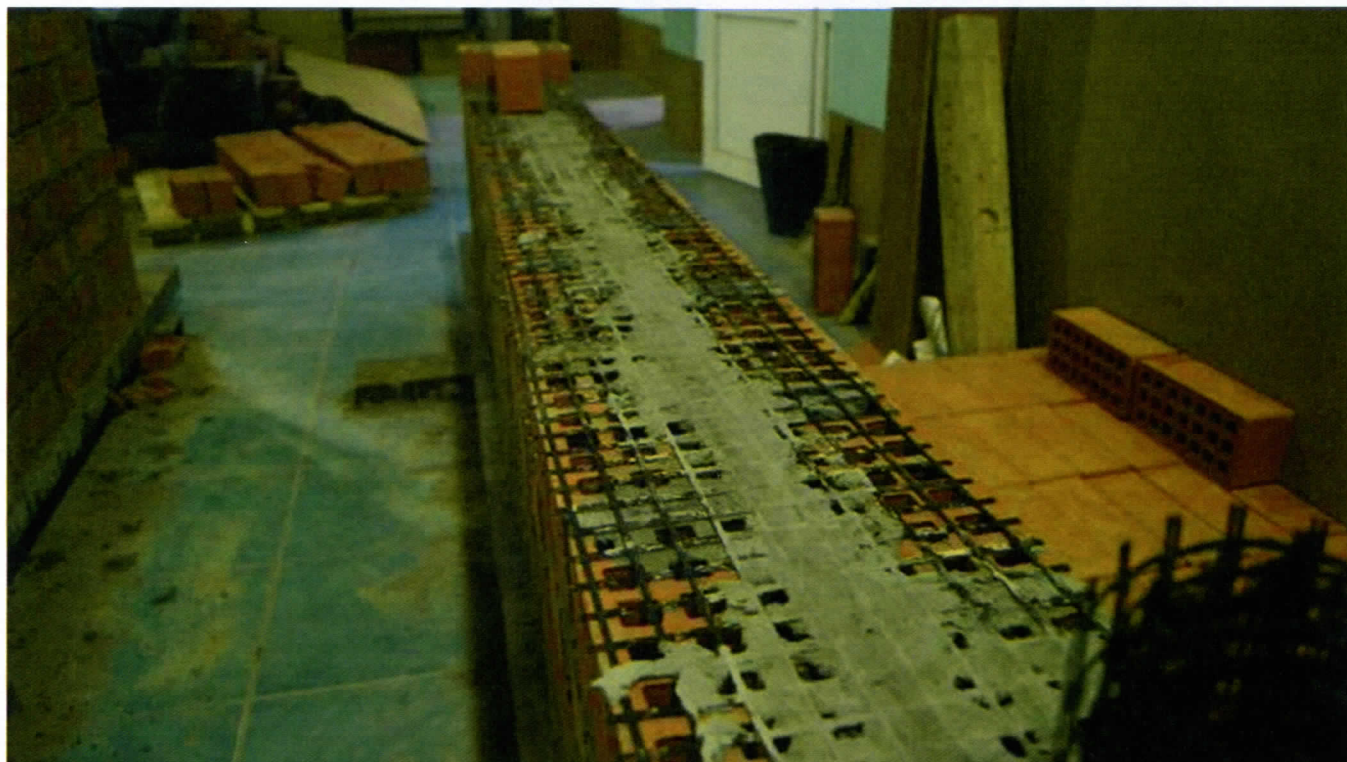
Рисунок 5.2.1 - Раскладка горизонтальной арматуры
